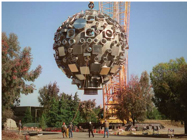
Рисунок 104: Монтаж камеры установки NIF (1999). С сайта [123].
