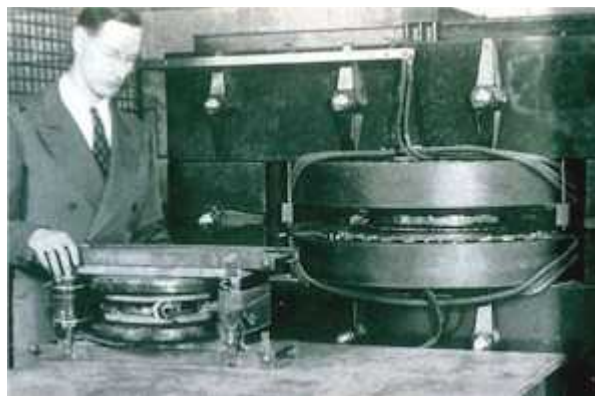
Рисунок 182: Д.Керст рядом с бетатронами на 2.3 МэВ (маленький) и на 25 МэВ (большой). С сайта [179]
