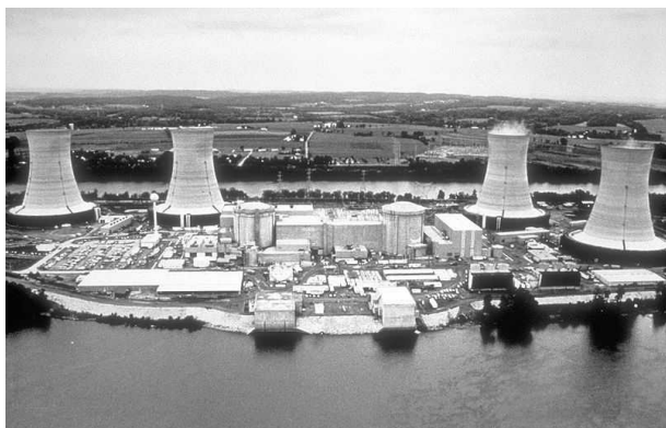
Рисунок 98: АЭС Три-Майл-Айленд. Второй энергоблок (на котором произошла авария) - справа. Фото сделано до аварии. С сайта [113].
